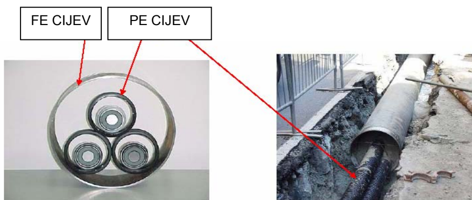
Slika 15. Provlačenje kabela kroz čeličnu cijev
