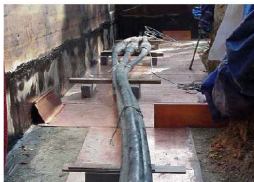
Slika 14. Bakreni oklop u montažnoj jami
